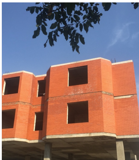
Работы по заделке торцов плит
